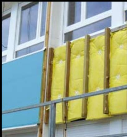
› Pose verticale en bardage sur ossature métallique
