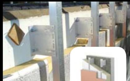
> Pose horizontale en vêtage sur fixation déportée
