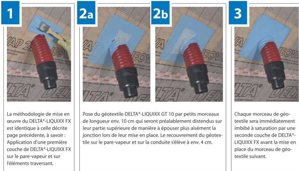
Figure 11 - Principe de mise en œuvre de la résine DELTA-LIQUIXX FX
